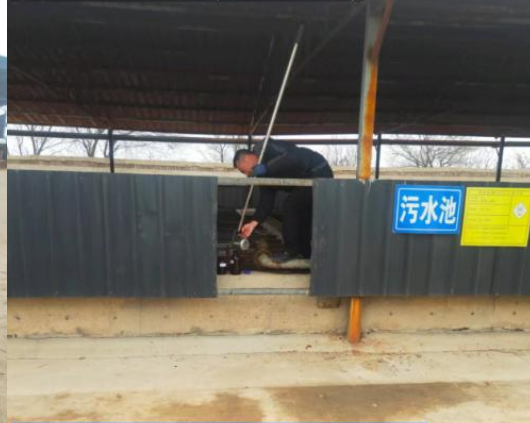
污水检测采样(生产废水)
